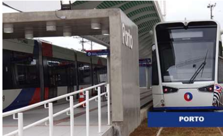
Figura 6 – Estação Porto do VLT
